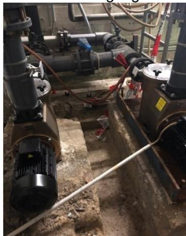
Neue Umwälzpumpen – los auf defekten Fundamenten
