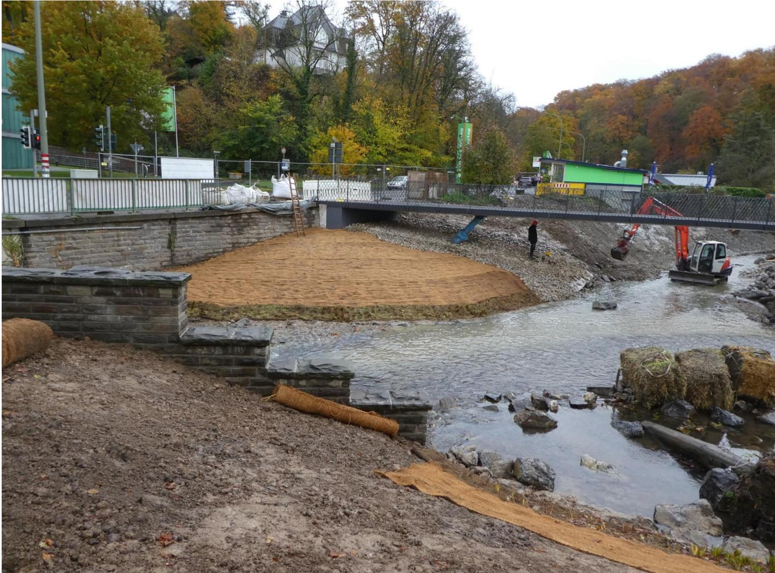
Aufbringen der Vegetationsmatten auf die Böschungen als Erosionsschutz im Bereich der Düssel
