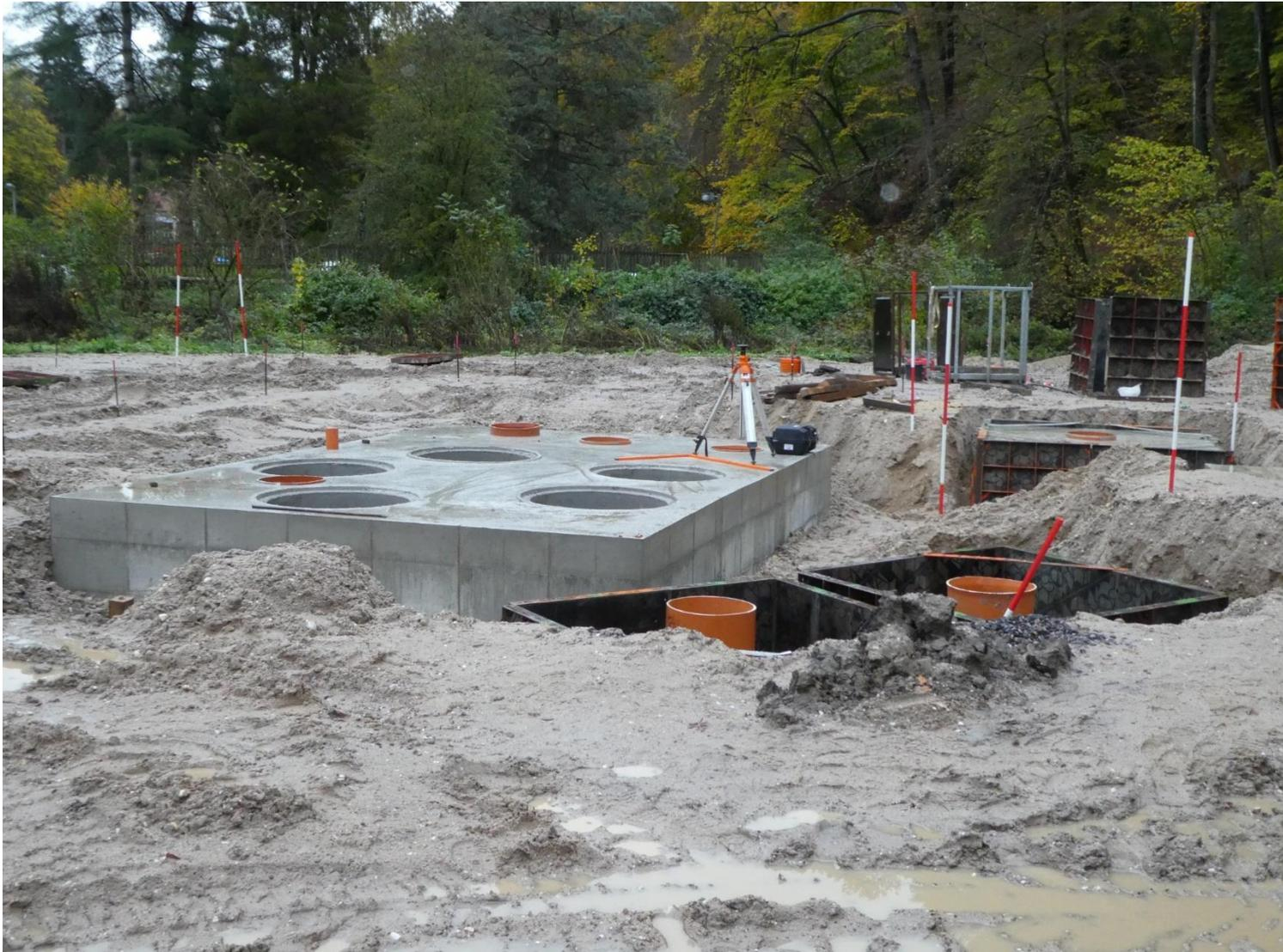
Herstellung des Fundamentes für den Pfahllanzenurm (Bereich M2b)
