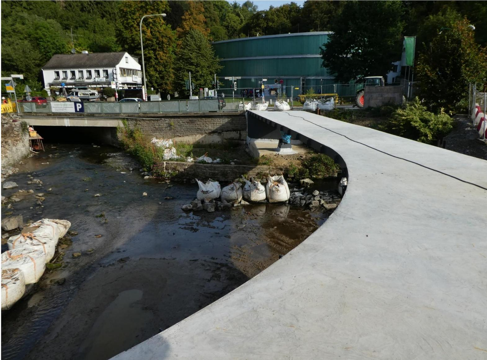
Herstellung des Fangedammes zur Einengung des Mettmanner Bachs für den Böschungsbau im Bereich des Widerlagers Nord der Museumsbrücke
