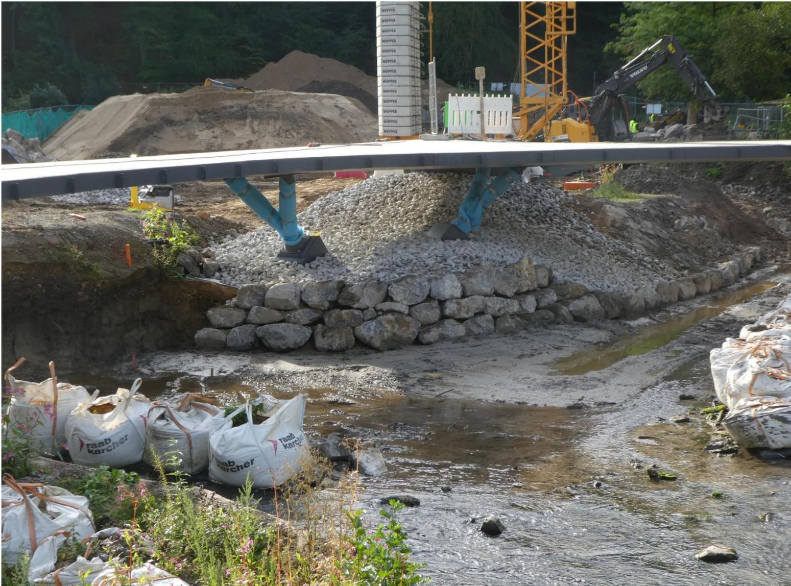
Herstellung der Uferböschung im Bereich des Mittelaufagers der Museumsbrücke
