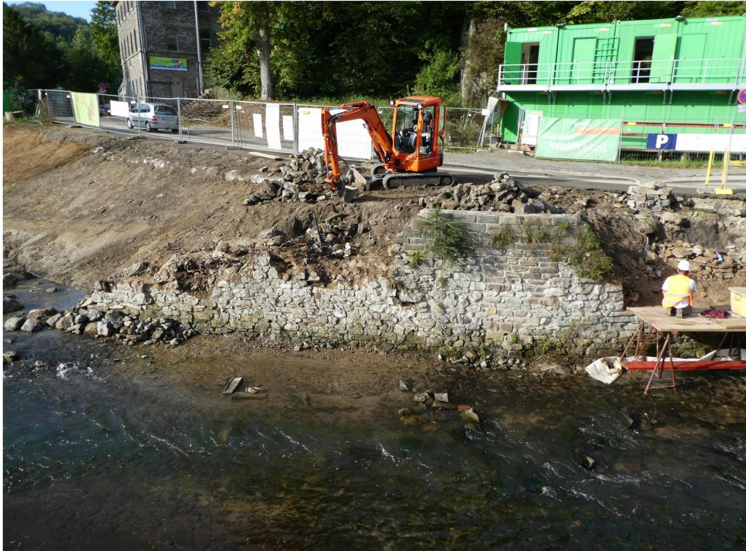
Herstellung der Abtreppung der alten Düselmauer
