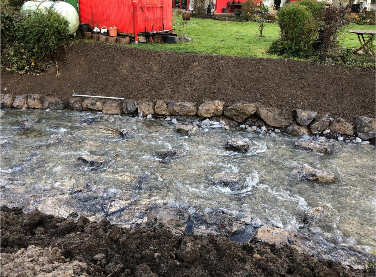
Herstellung der Sohlgleite im Mettmanner Bach - Einbau der ersten 6 Riegel mit Störsteinen
