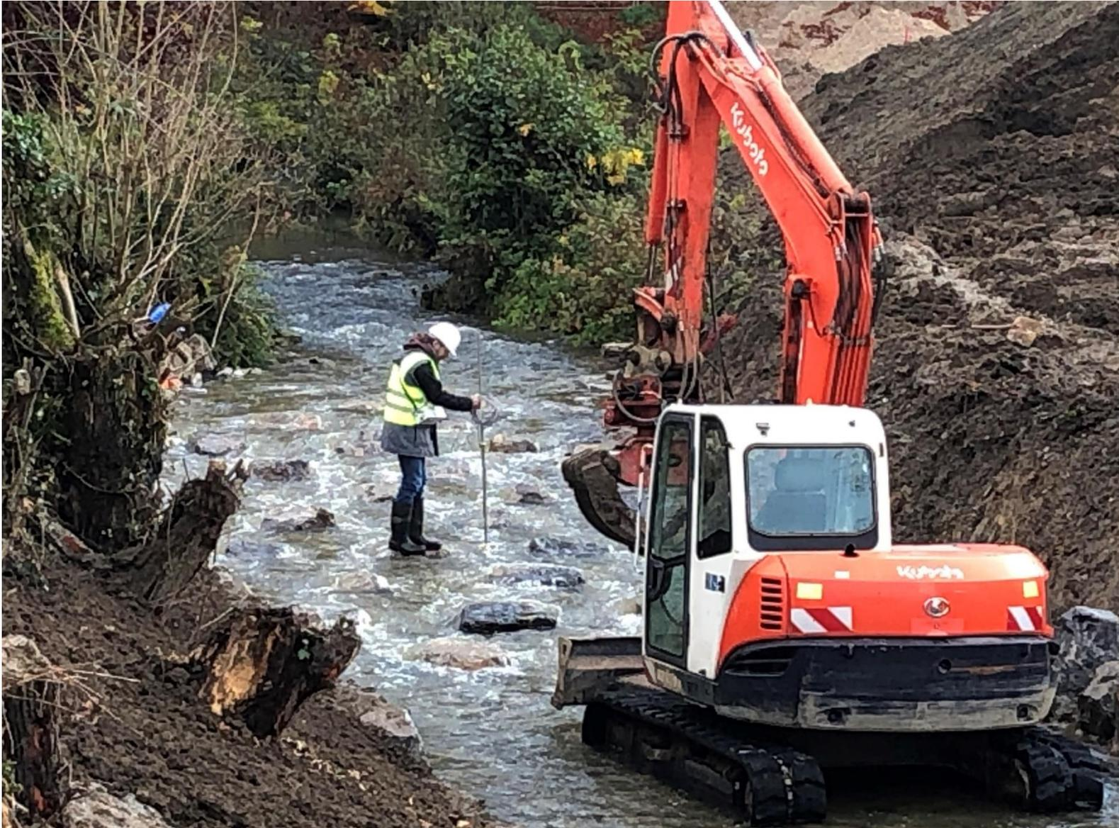
Herstellung der Sohlgleite im Mettmanner Bach – Überprüfung der Fließgeschwindigkeiten zwischen den Störsteinen durch den BRW
