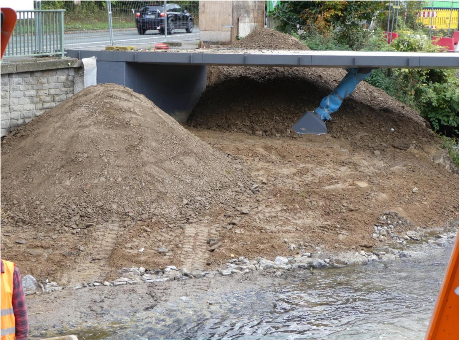
Herstellung der neuen Böschung im Bereich des Widerlagers Nord der Museumsbrücke
