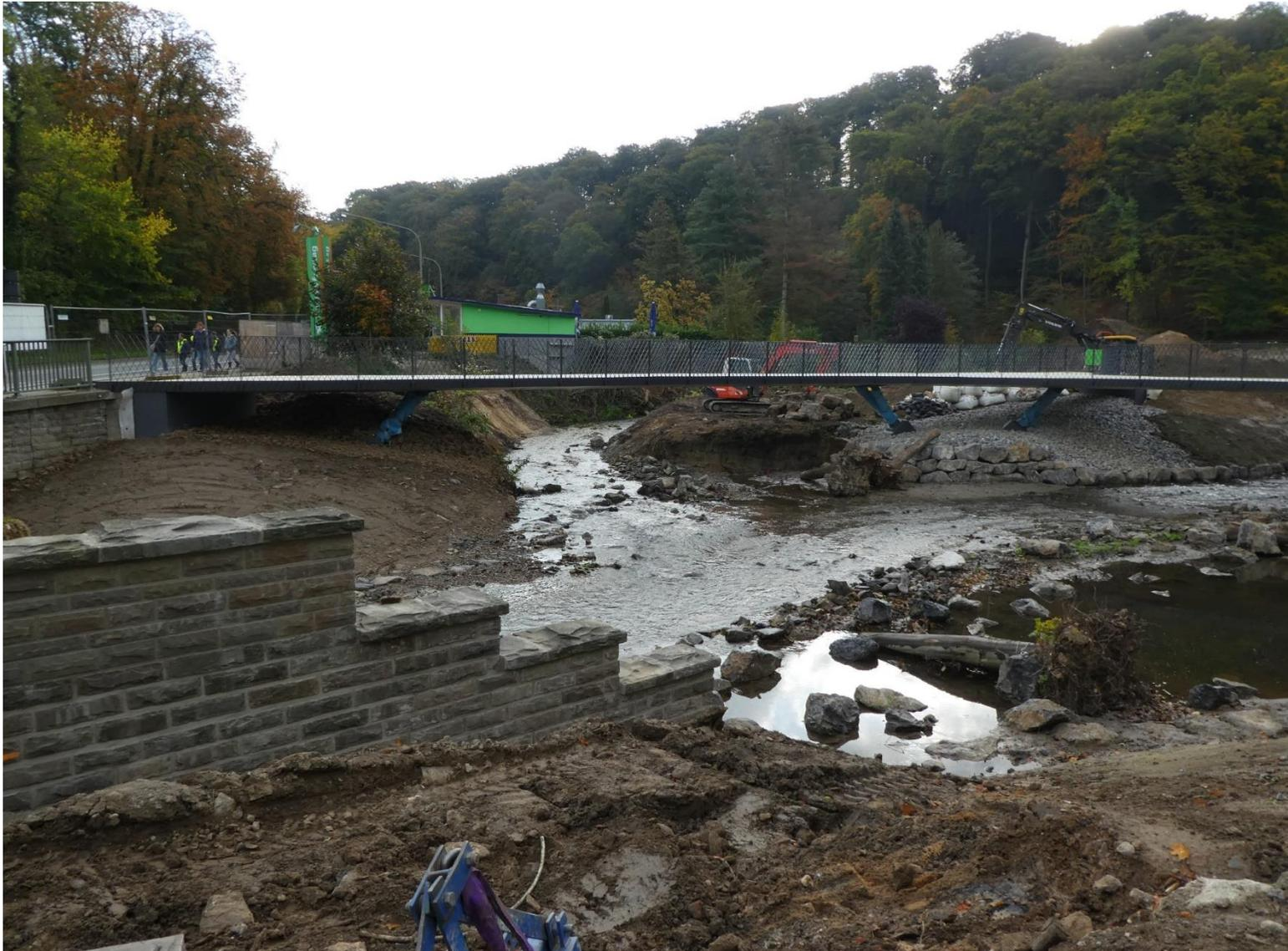
Herstellung Böschung im Bereich des Widerlagers Nord der Museumsbrücke und Herstellung des neuen Gewässerbettes des Mettmanner Bachs
