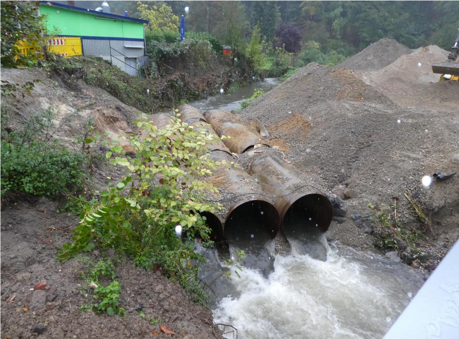
Rückbau der bauzeitlichen Verrohrung des Mettmanner Bachs
