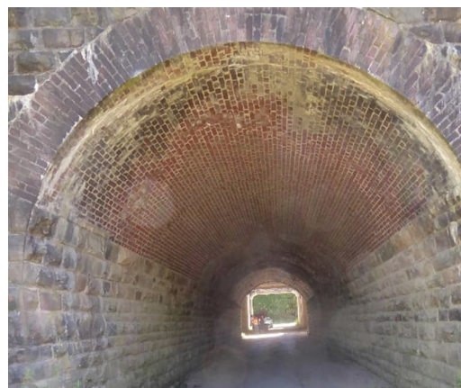
Abbildung 3: Brückenbauwerk EÜ Iserkull, Nordteil, Blickrichtung Süd, 27.06.2019.
