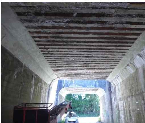
Abbildung 2: Brückenbauwerk EÜ Iserkull, zu erneuernder Südteil, Blickrichtung Süd, 27.06.2019
