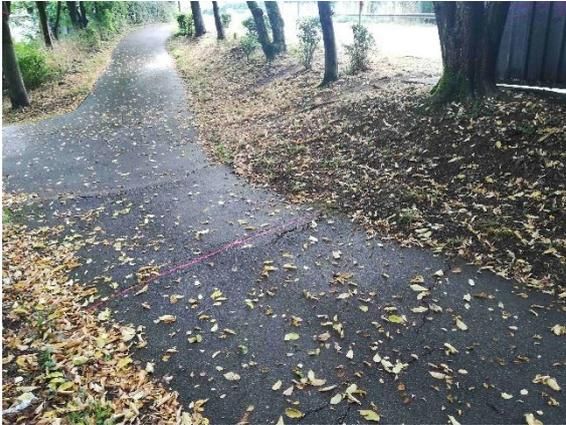
Foto 7: ... die den Asphalt anheben
