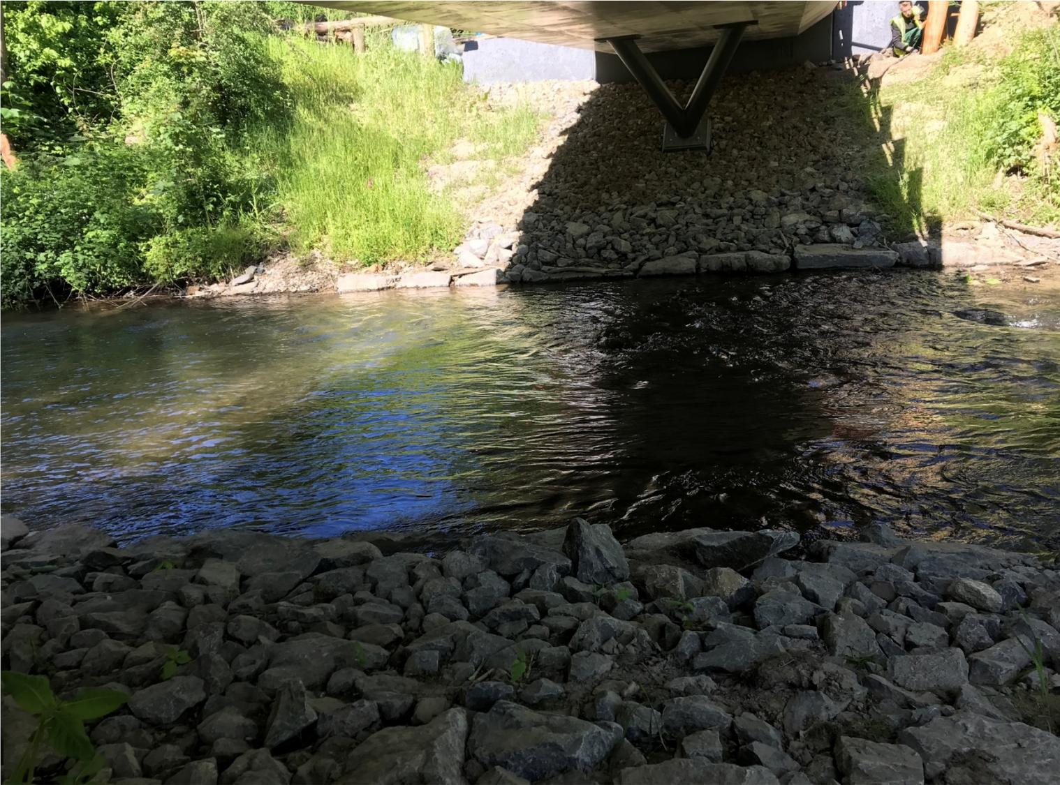
Fertiggestellte Böschung im Bereich der Widerlager der Spielplatzbrücke
